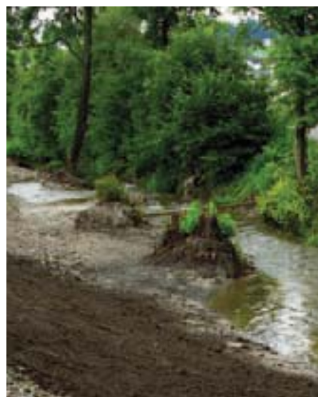
Verbreiterung des Gossauer Bachs mit mäand. steilen Böschungen.
