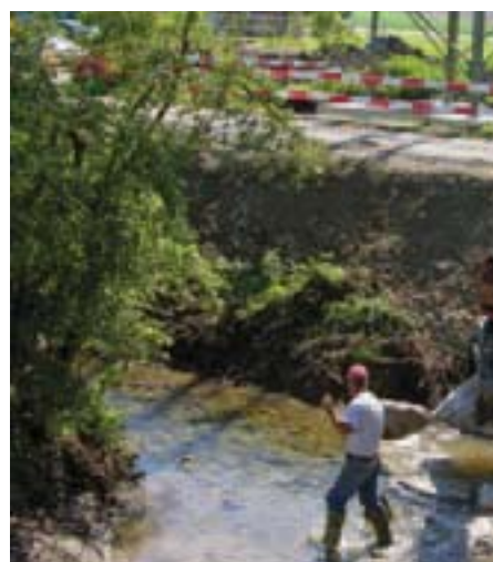
Unterbrechung des Wasserflusses mit Blockw.
