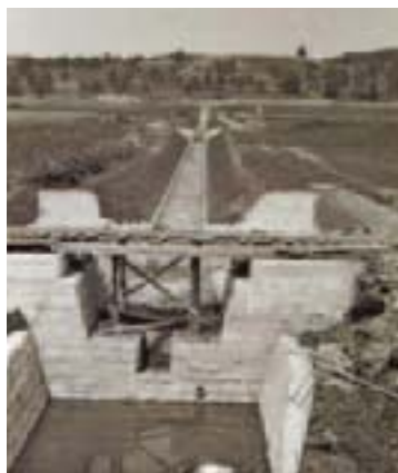
Verlegung Gossauer Bach, 1943.
