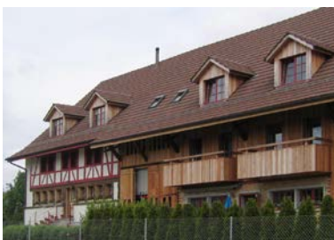
Beispiel Sanierung eines Anbaus
