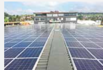
8625 Gossau | Leistung 223,6 kWp Schrägdach | Trapez
