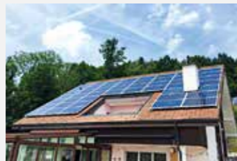
8636 Wald | Leistung 11,44 kWp Schrägdach | Eternit
